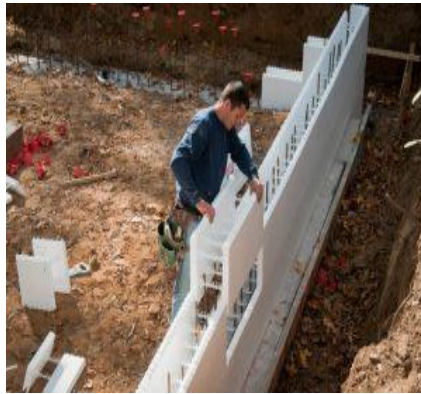
Fig. 14.1.3 (d) Insulating Concrete Formwork (ICF) Technique
